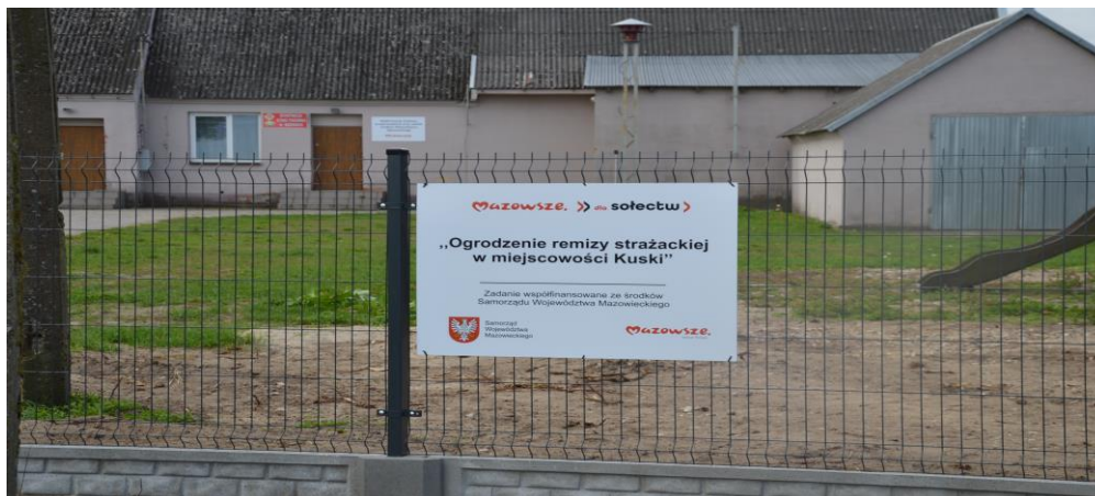
Ogrodzenie remizy strażackiej w Kuskach.
