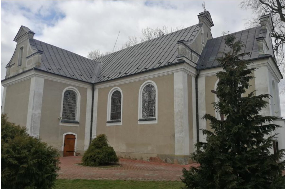
Fot. 3 Fragment elewacji południowej z kaplicą południową (narożnik południowo-wschodni)
