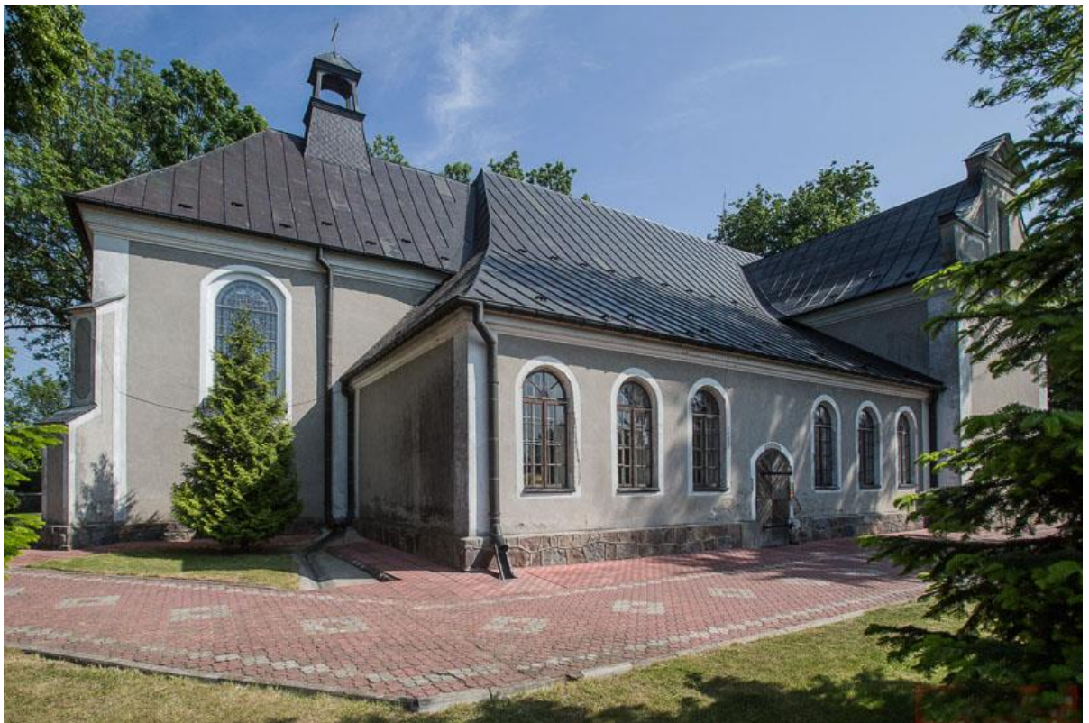
Fot. 4 Fragment elewacji południowej z zakrystią
