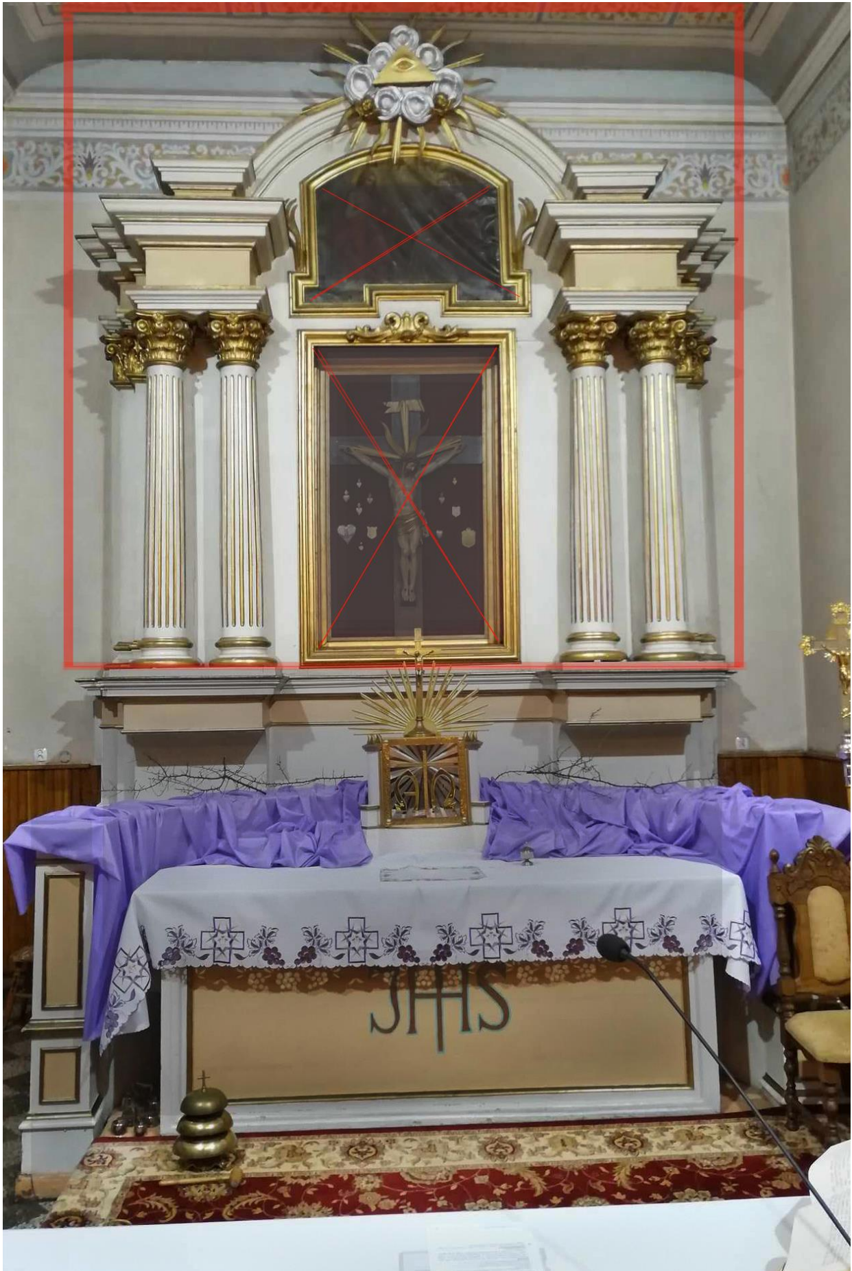
Fot. 17 Ołtarz główny. Zakres prac objętych PFU.
