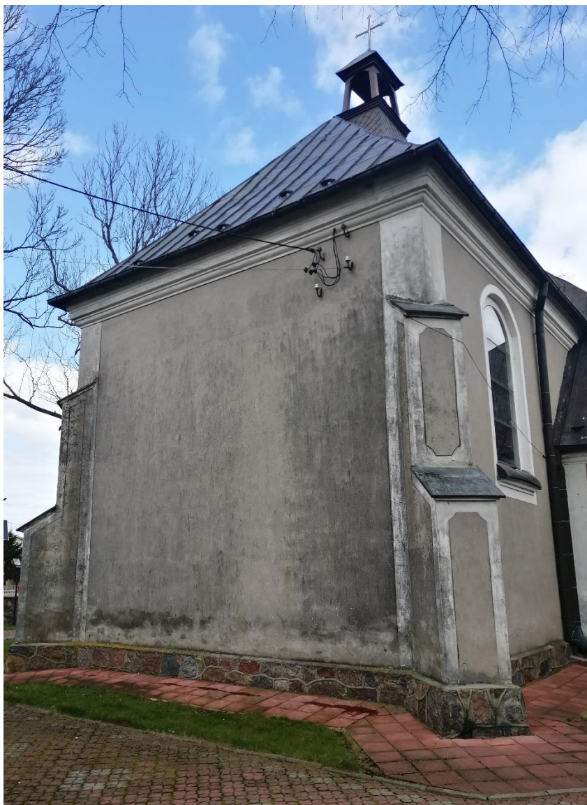
Fot. 5 Fragment elewacji zachodniej, narożnik zachodnio-południowy
