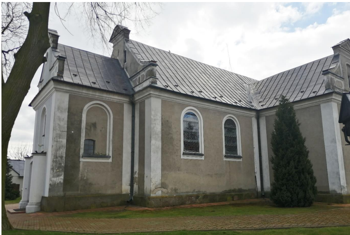
Fot. 7 Fragment elewacji północnej (narożnik północno-wschodni)
