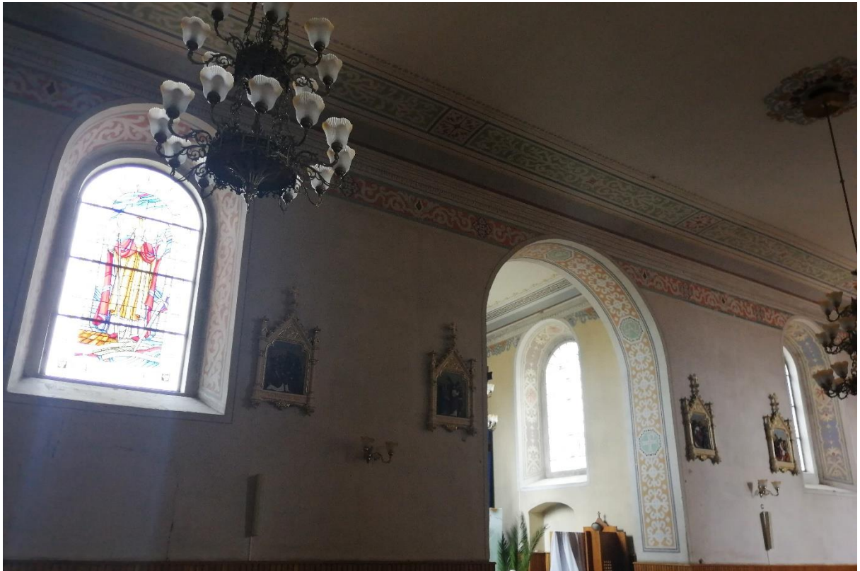
Fot. 13 Fragment ściany północnej w nawie z arkadą otwartą na kaplicę północną
