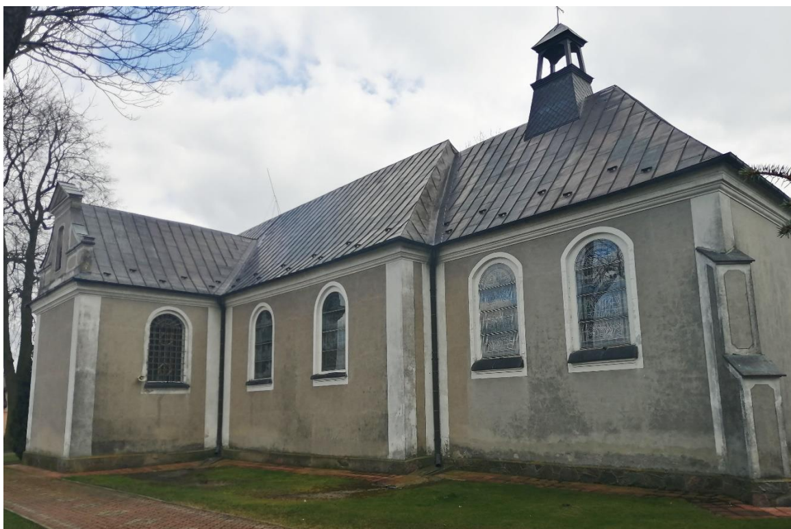
Fot. 6 Fragment elewacji północnej z kaplicą północną (narożnik północno-zachodni)
